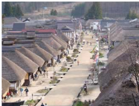
裏配線による整備事例【大内宿（福島県）】
