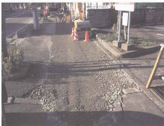
写真-3 人孔突出部の切断後、砕石にて埋戻し
