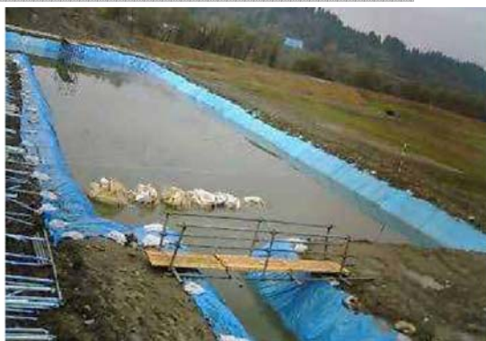
写真-4 仮設沈殿池の設置
