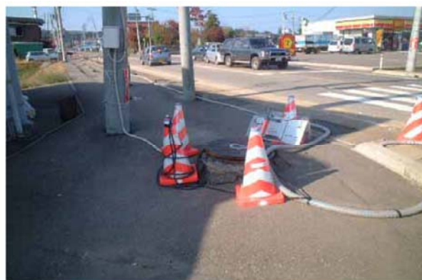
写真-5 仮配管・仮排水ポンプの設置
