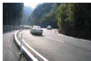
2車線+歩道整備
