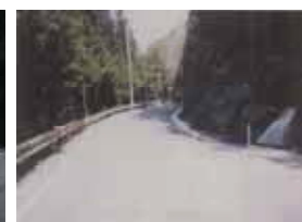
1車線+待避所設置
