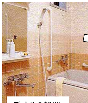
手すりの設置
