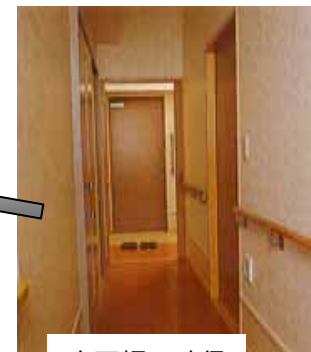
廊下幅の確保
