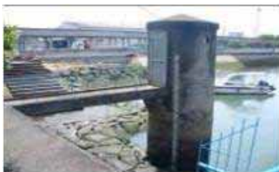
潮位計等の観測施設の設置
