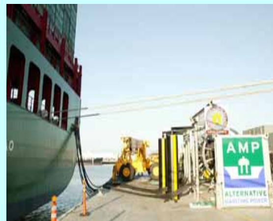
陸電ケーブル接続状況
