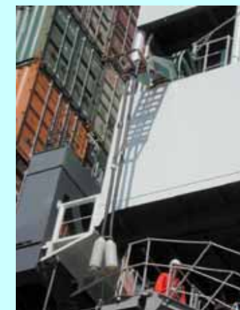
船舶側受電ケーブル
