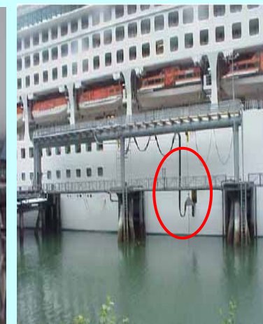
陸電ケーブル接続状況
