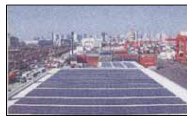
ゲート屋根へ太陽光パネルを設置
