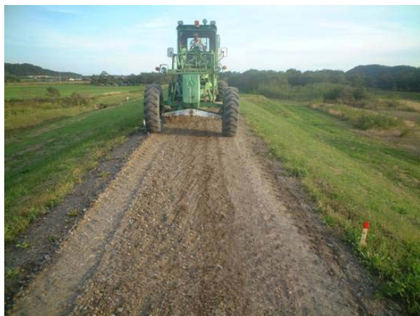
堤防の維持管理
