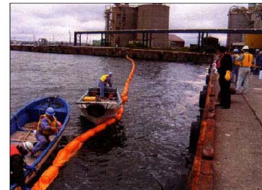
流出されたA重油の回収状況
