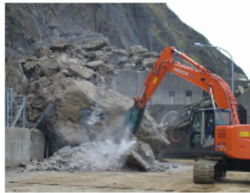
現地参集(22:00)→掘削開始8:00
