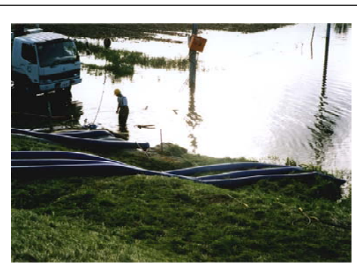
内水排除作業
