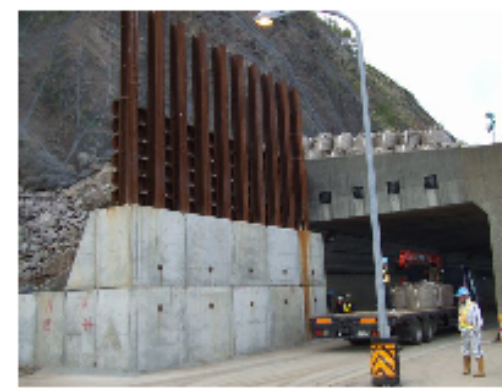
落石防護柵設置完了・供用(59時間後)
