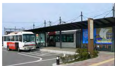
■写真 3.2.5 駅前広場整備(地域生活基盤施設)とフィーダーバス社会実験(提案事業)
