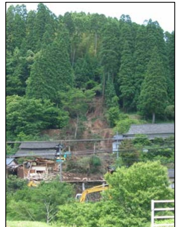
H20.6大分県九重町 がけ崩れにより1人死亡
