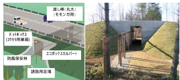
図1 ボックスカルバートの設置状況
