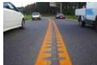
図5 ランブルストリップス設置状況
