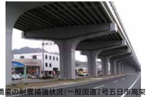
橋梁の耐震補強状況（一般国道2号五日市高架橋）
