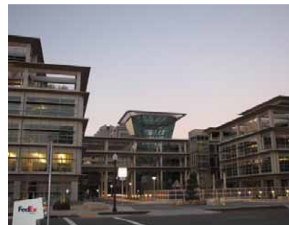
図 CalPERS本部ビル(LEED Gold)
