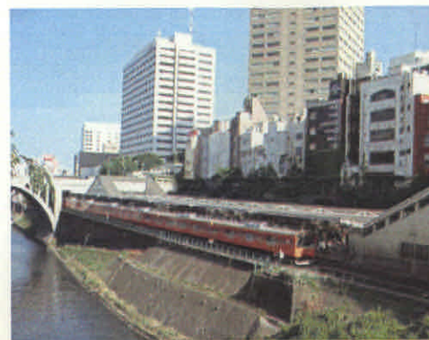
斜面と神田川に挟まれた駅舎
