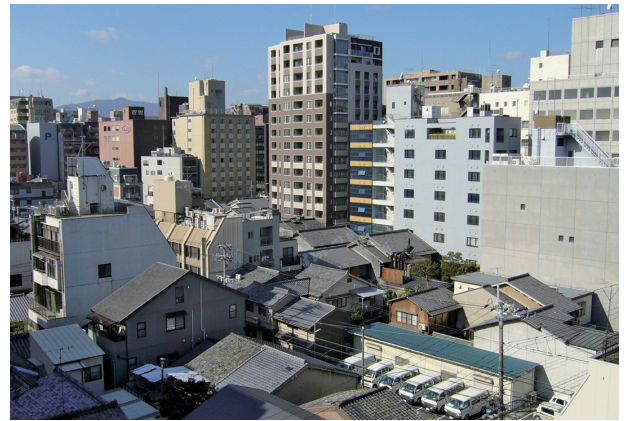
御池通から一筋南に位置する姉小路界限地区 御池通沿いには高層マンションが林立
