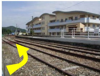
三ヶ日駅構内におけるDMV進入設備設置予定地
