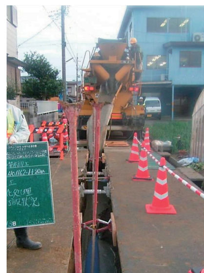
写真：流動化処理土打設状況
