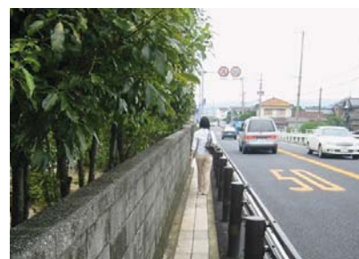
＜防護柵の設置＞
