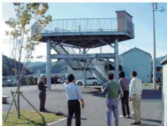
津波避難タワー
