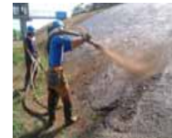
地域から発生する浄水汚泥と家畜糞尿堆肥を法面植生基材として有効利用。
