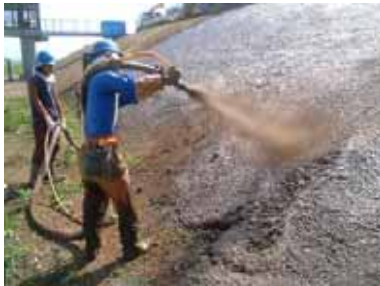
地域から発生する浄水汚泥と家畜糞尿堆肥を法面植生基材として有効利用。
