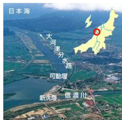
写真 2-5 大河津分水路
