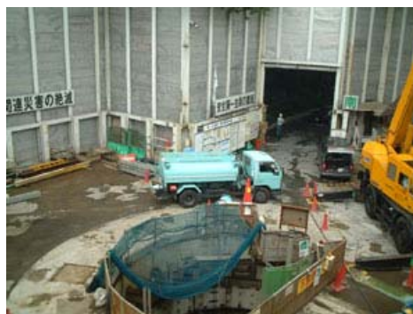
もとは下水道の工事現場(H13.7)
