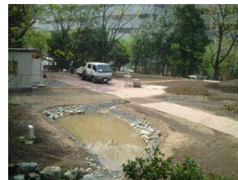
基盤工事が完了(H15.4)
