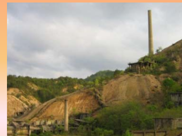
【尾去沢鉱山跡(秋田県鹿角市)】
