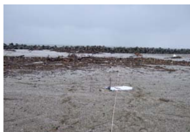
状況写真①前
