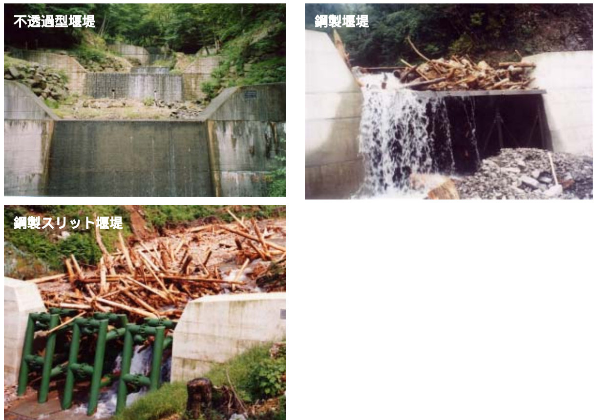
図 2.1 - 26 流木捕捉効果のある治山事業の施工例
