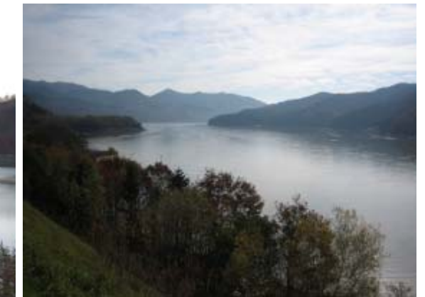
写真5 ダム貯水池上流
