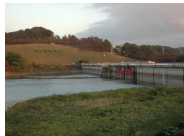
写真3 四十四田ダム(上流側)
