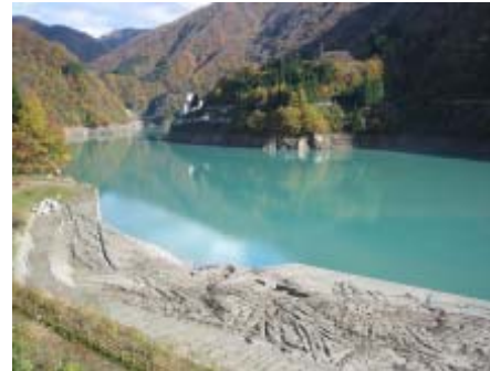
ダム貯水池の状況 (水位低下のため網場取り外し中)
