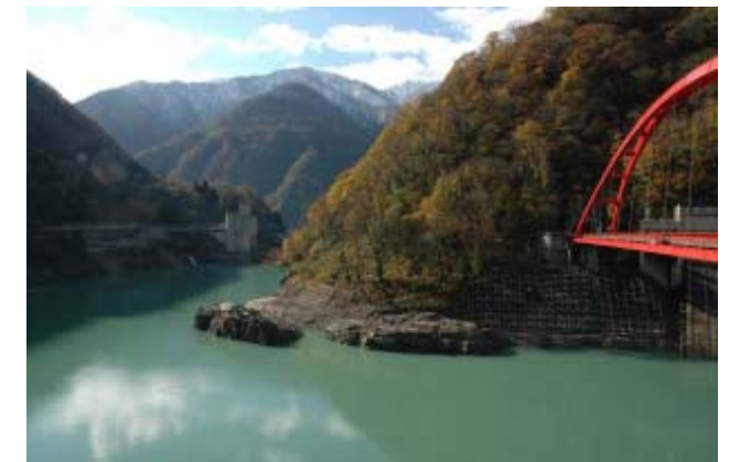
写真2 ダム貯水池上流
