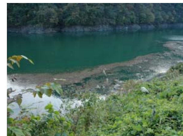
写真3 ダム貯水池内に堆積する流木
