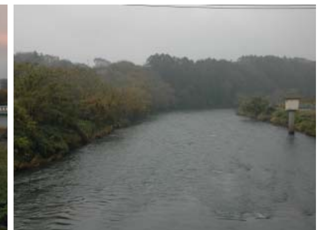
写真6 ダム貯水池上流
