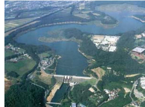
写真1 四十四田ダム（航空写真）
