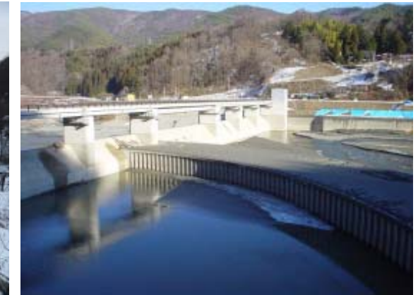
写真 4 トラップ堰（バイパス水路入口前面）
