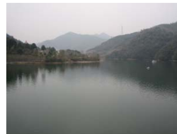
写真 1 ダム貯水池の状況
