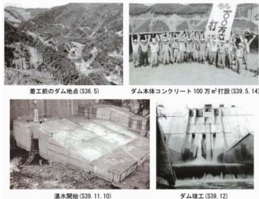
図 2.3 - 17 鶴田ダム建設の経緯
