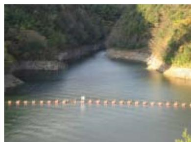
写真-4 入江地形に堆積させないための措置
