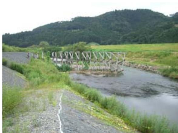
写真2 砂鉄川流木捕捉施設
