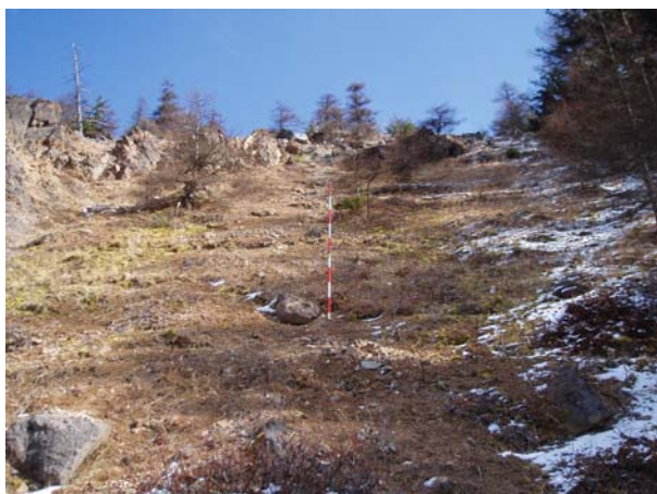
湯ノ丸山腹工（6年経過） 半分程度の割合で裸地が存在し、施工された筋工等は現在ではみられない。
