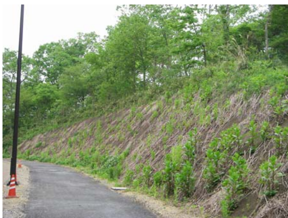
施工地の現状
