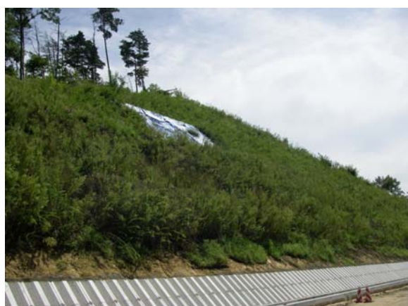
施工地の現状
