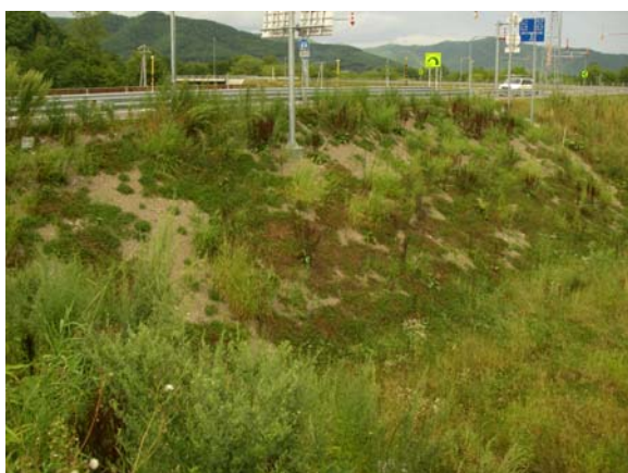
施工地の現状
