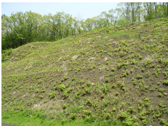
施工地の現状
