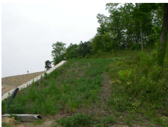
施工地の現状
