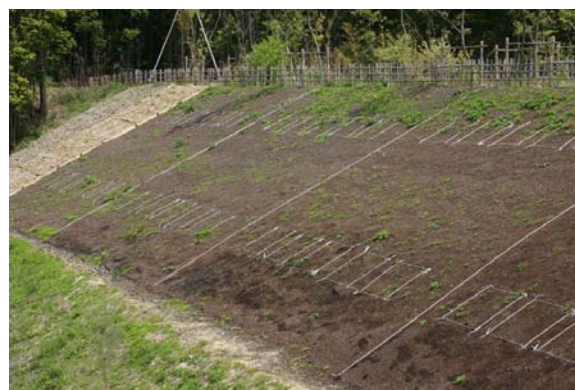
植生基材を吹き付けた法面の現状
