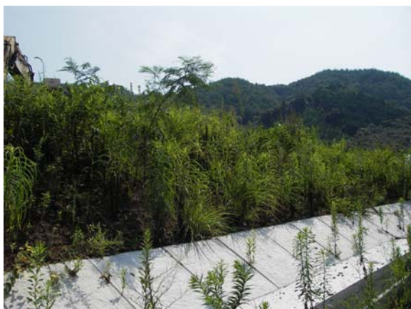
施工地の現状
