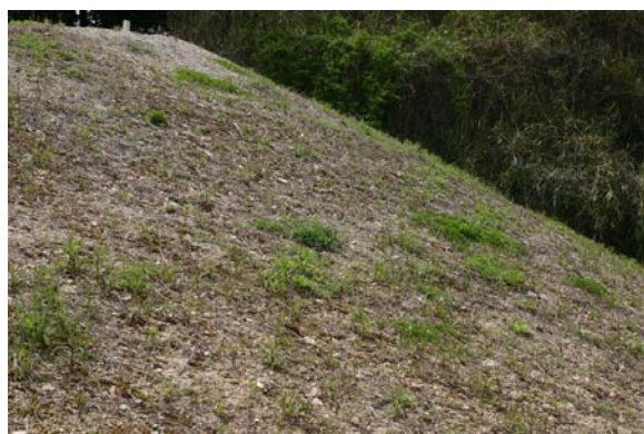
ワラシートを敷設した法面の現状
