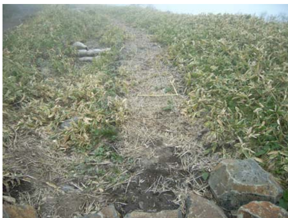
施工地の現状
