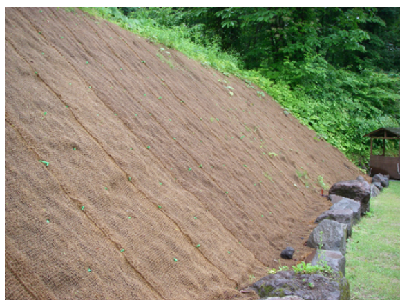
敷設したヤシ繊維ネット
