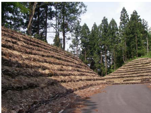
裸地が広がる施工地の現状
