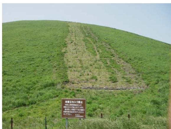
施工地の現状
