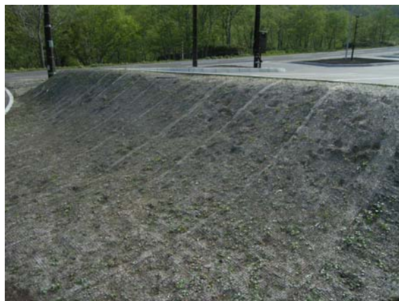
敷設した植生シート
