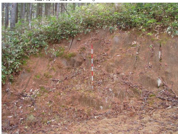
中御所治山作業道（1年経過） 作業道の切土のり面に使用した ヤシネットによる無播種工法
