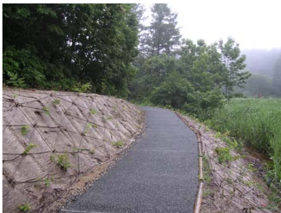
施工地の現状
