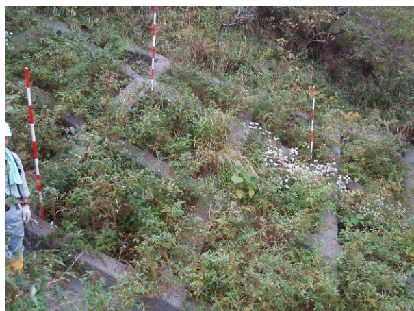
外早川山腹工 樹林化工法（2年経過）の状況
