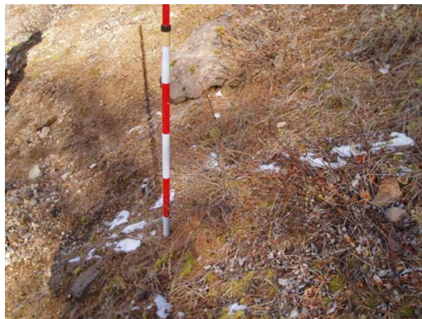
湯ノ丸山腹工（6年経過） 筋工の跡地付近に定着したカラマツ（60cm） その他バッコヤナギなどもみられる。
