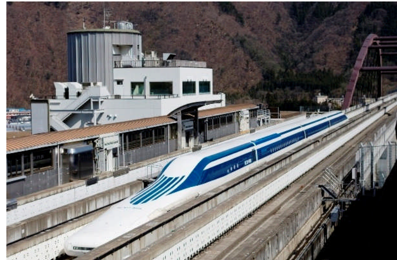
山梨実験センター及び走行試験中の超電導リニア車両
