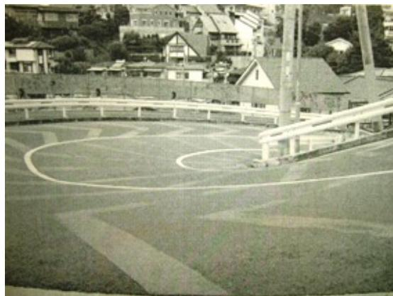
**B:** 交差道路、橋等との接合部に生じた段差に起因するもの。幹線道路から団地への侵入路などに比較的多く見られる。また、橋との接合部は経年変化による場合も考えられる。
