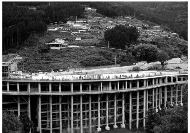
かずら橋のすぐ側に43億円を投じて整備された駐車場 (過疎地ではこのような施設が比較的容易にできてしまう)
