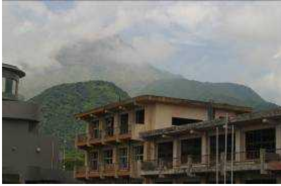
普賢岳災害校舎（旧大野木場小学校）
