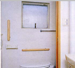
玄関・トイレ・浴室に手すりを設置、木製建具の幅を広くするなどの改良を実施
