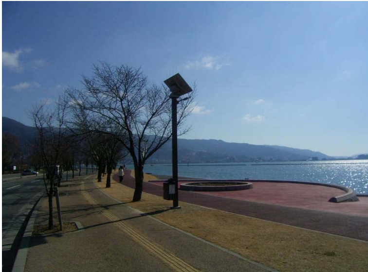
取組②自動追尾ソーラー発電LED歩道照明灯設置状況
