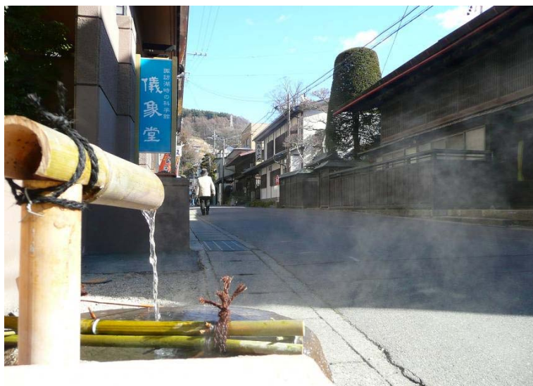
取組①温泉掛け流し施設設置状況
