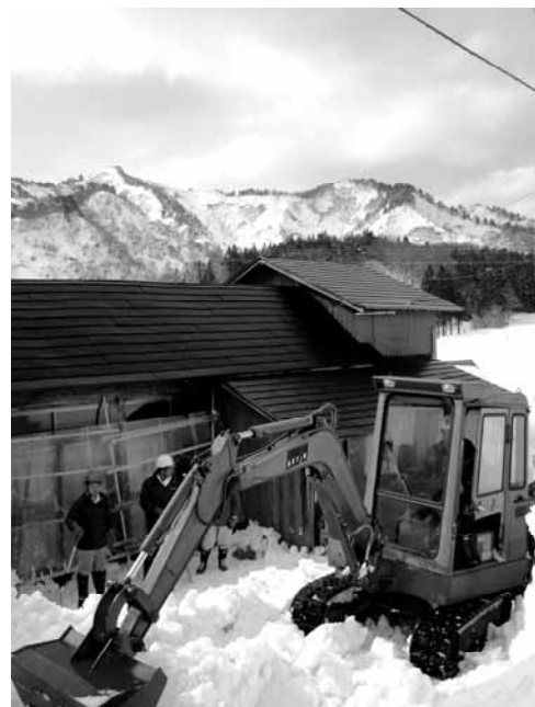
高齢者宅周辺の一斉除雪作業（機械力）
