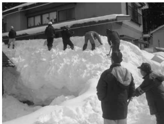
（安全管理係が見守りながらの作業）
