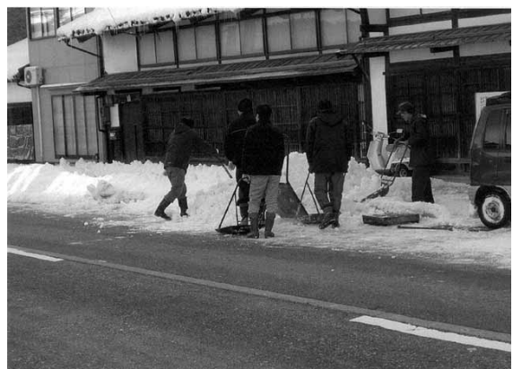
流雪溝を利用した歩道の一斉除雪
