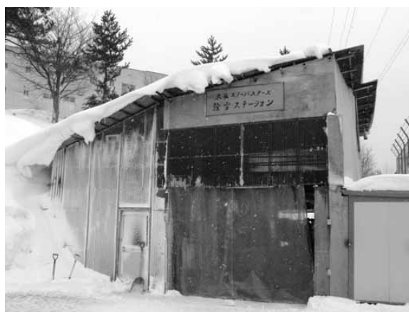
赤坂スノーバスターズ 除雪ステーション
