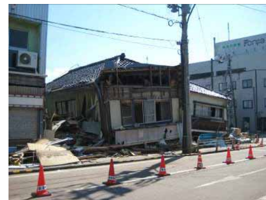
被災後の現地の状況
