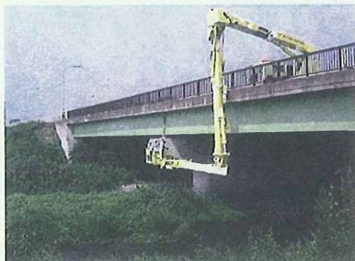
【橋梁点検の例】
