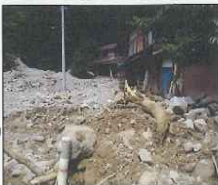
土砂災害により 人家2戸半壊 (南砺市)
