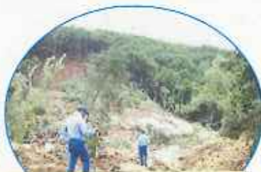
被災状況調査班 (土砂災害危険箇所)
