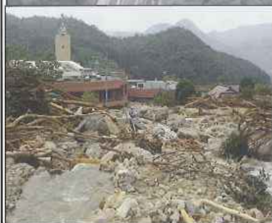
山口県防府市 （特別養護老人ホーム） 被災状況
