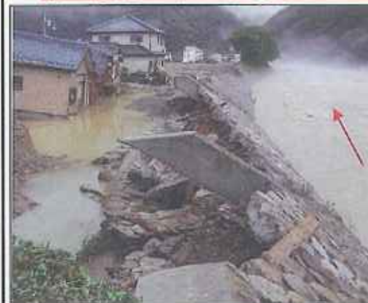
佐用川 （兵庫県佐用町久崎） 被災状況
