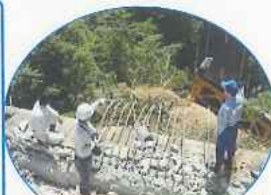
被災状況調査班(道路)
