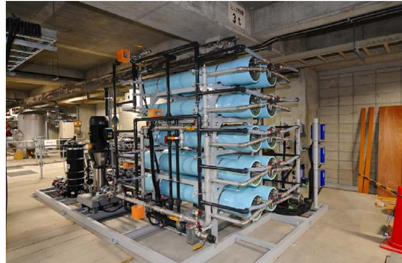
RO膜処理ユニット
