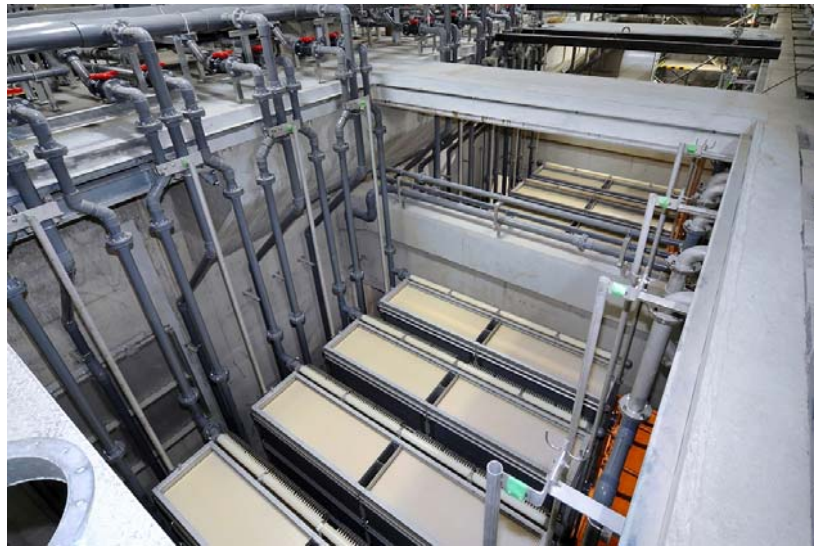
好気タンク内に設置した平膜ユニット
