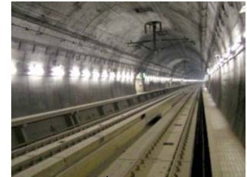
青函トンネル
