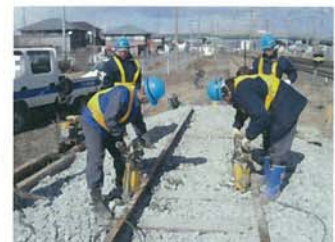
バラスト突き固め (一般区間)
