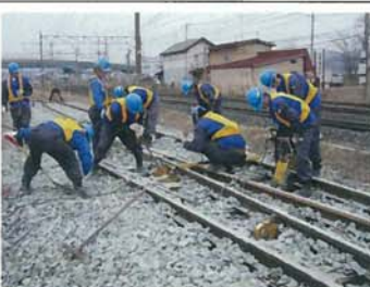
バラスト突き固め (分岐区間)
