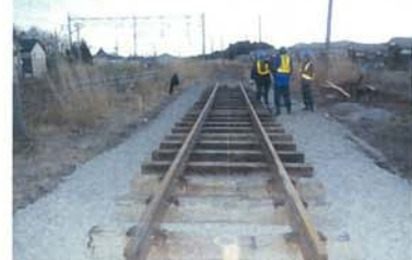
レール&マクラギ設置
