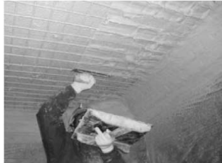
▲ 増厚工法による補強
