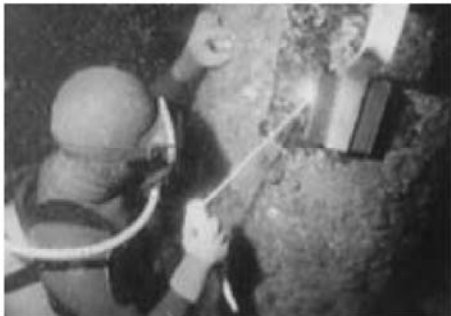
▲ 水中溶接による電気防食の施工
