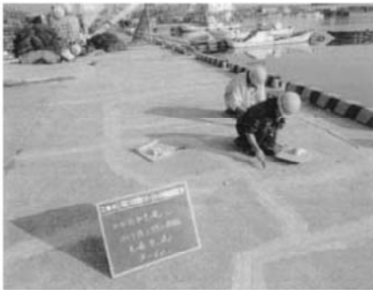
▲ エプロンのひび割れに樹脂を充填
