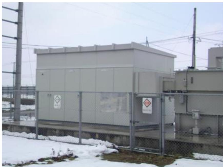
風力発電設備から電力会社の系統に接続するための昇圧設備（高圧から特高）
