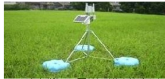
観測機器設置状況(柴島浄水場)
