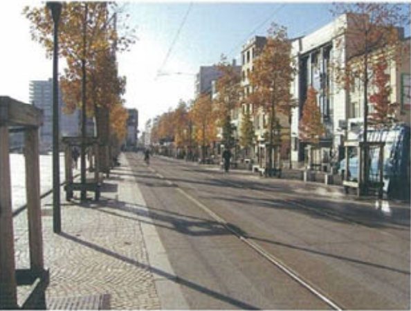
(左、左下) 広場内にフラットな軌道が通されている事例 (Clermont-Ferrand)
