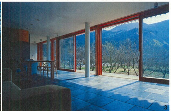
3 南面を大きく開いて日射を取り入れている。石張りのコンクリート床(厚さ90mm)だけでは蓄熱性に欠けるため、両妻壁と3カ所の間仕切り壁をコンクリートブロックの化粧積みとして室内の熱容量を増やし、外が氷点下4℃に冷え込む早朝でも室内は15℃を保つと予想した。ほぼこのシミュレーション通りの結果が出ており、ご家族も満足している様子だ。4 せせらぎが聞こえるほどすぐ目の前に川が流れる栗林の中の家。冬はしばしば氷点下まで気温が下がり、1月の平均気温は約3℃。しかし日射量には恵まれていた。撮影/岩為
