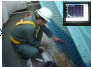
超音波による非破壊検査
