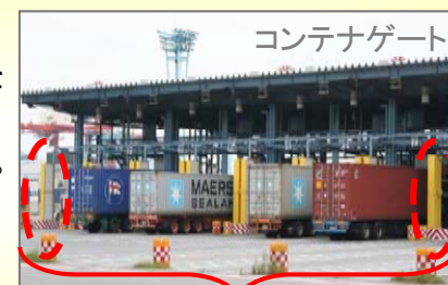
放射線検知施設 横浜港南本牧ターミナルの例
