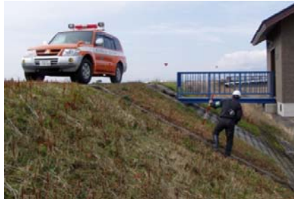
河川の巡視状況
