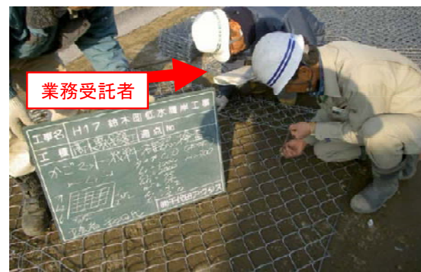
（河川護岸用かごマットの材料確認）
