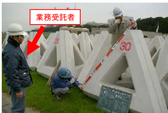
（根固めブロックの材料確認）
